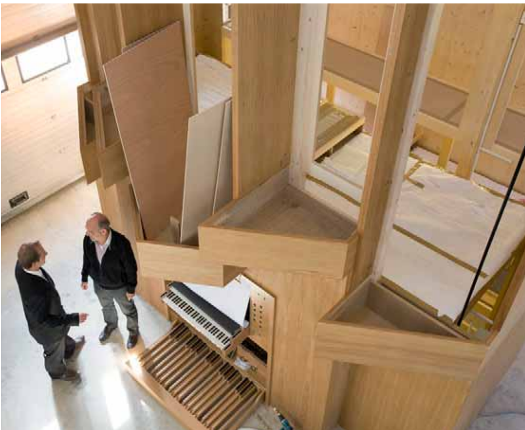
Königin der Instrumente: Die Orgeln von Thomas Jann wachsen in der Montagehalle oft mehrere Stockwerke in die Höhe.
